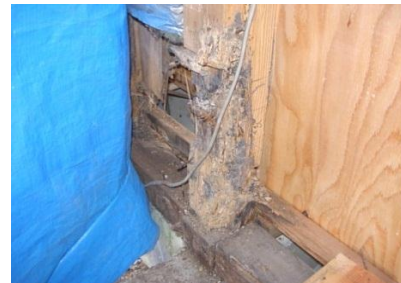
浴室の柱への被害
