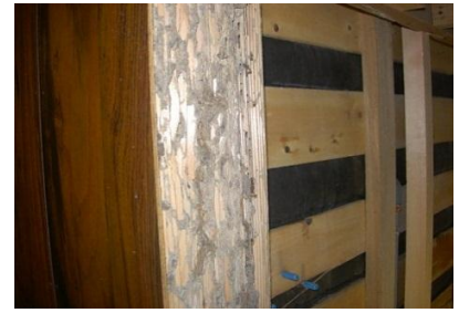
浴室の柱への被害
