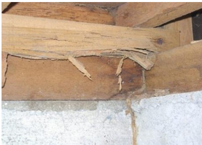
浴室キッチン側土台周辺の被害(床下)
