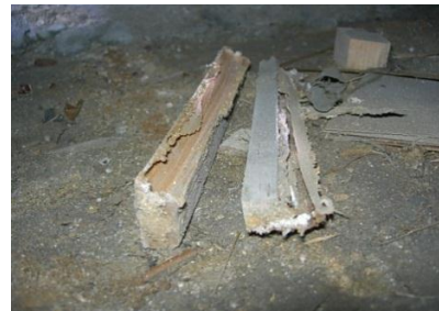
浴室キッチン側土台周辺の被害(床下)
