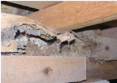
浴室キッチン側土台周辺の被害(床下)
